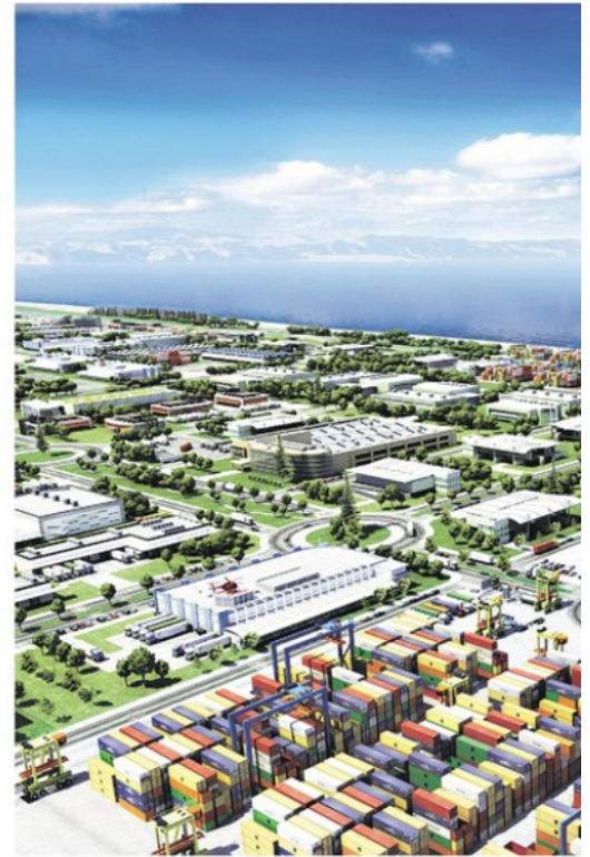
EL PROYECTO forma parte de un gran sistema logístico regional que integra armóculos lucrados. Al concepto macro se le denomina Región Plataforma.
